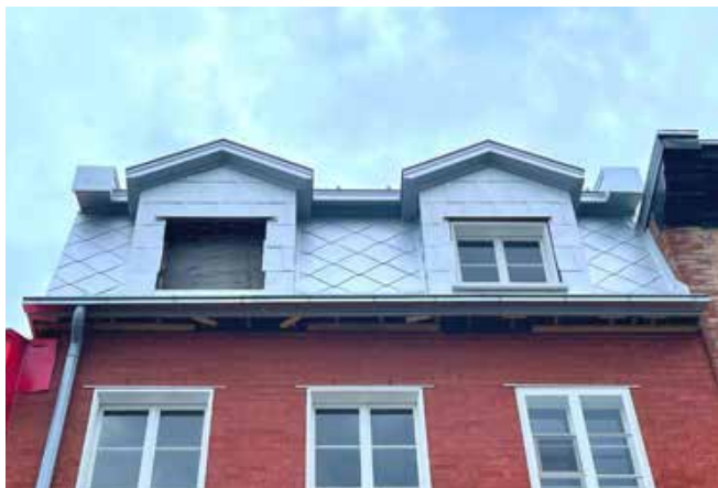
INSTALLATION AU TOIT
